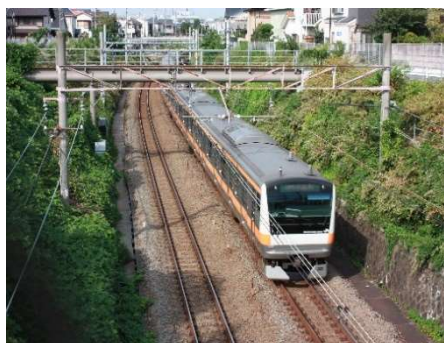
中央線の上をパイプで渡して、通っています
